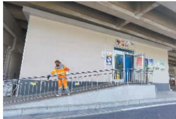
■槐安路与青园街交口的续建公厕投入使用。
