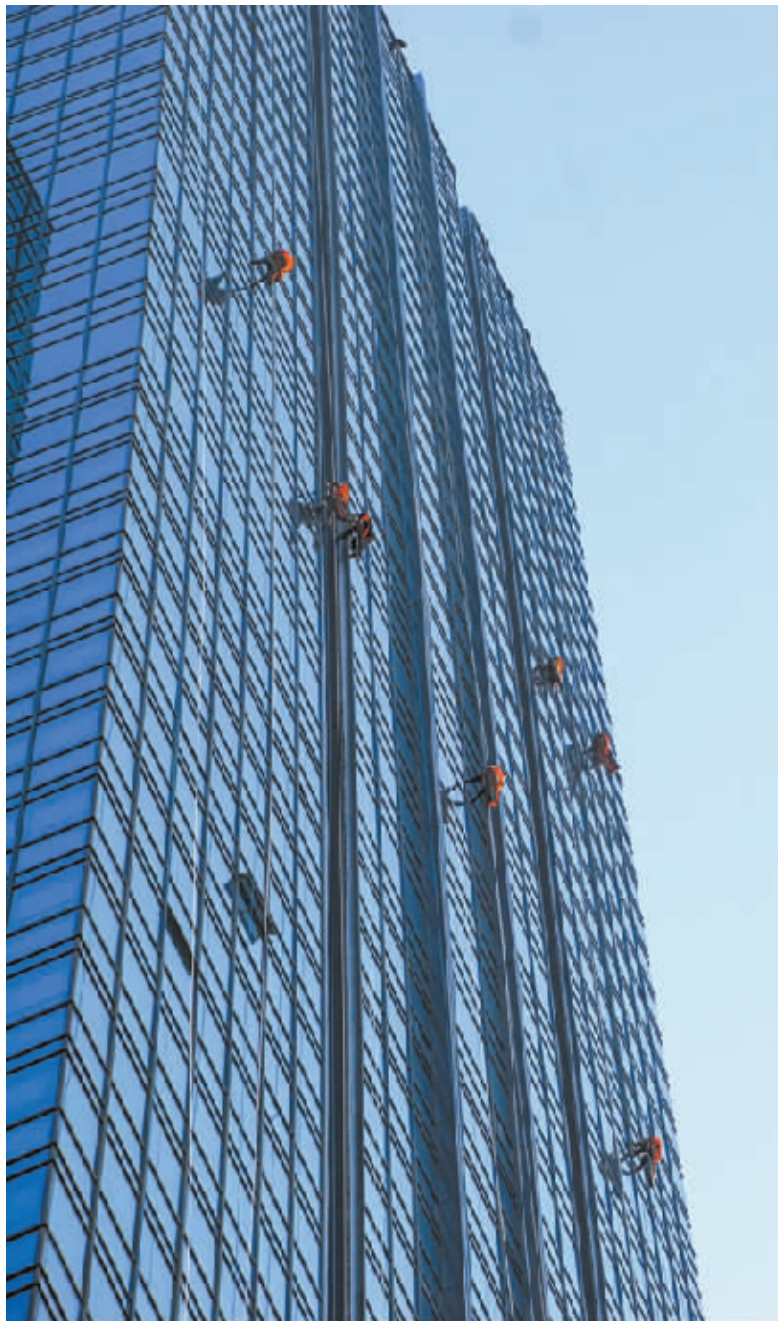
■施工人员在 200 多米高的大楼外侧进行施工。
