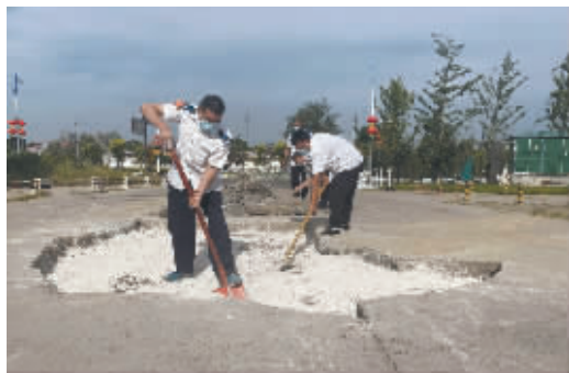
■路面修补现场。(公交公司供图)
