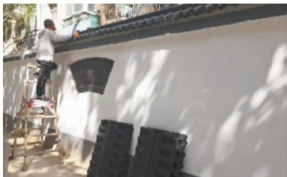
■工人师傅正在施工中。
