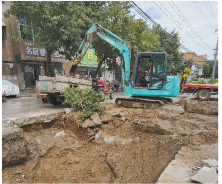
■易县县城紧急抢修道路。
