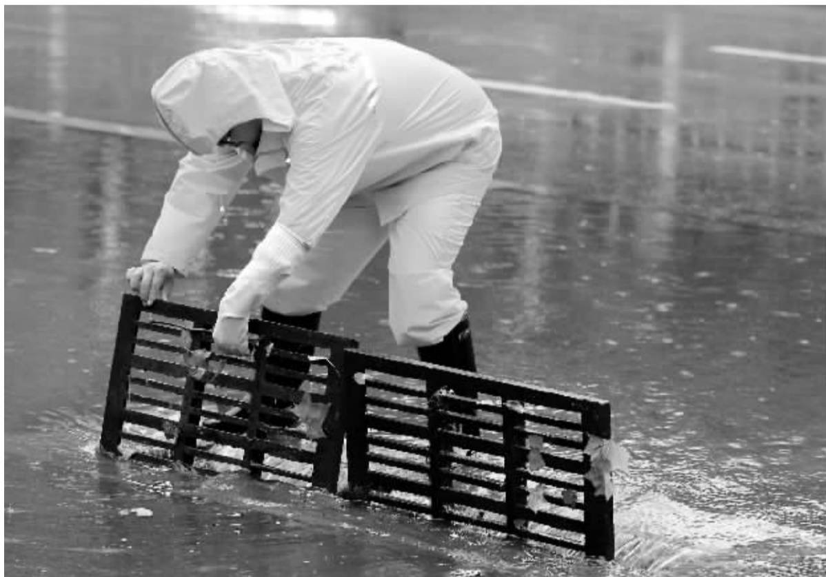
11日,排水处维护三所的工作人员清理排水口处的杂物。本报记者 张海强 摄
