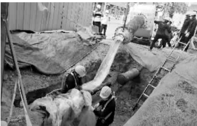
■裕德巷过翟营大街 DN300 天然气管道内衬修复工程现场。
