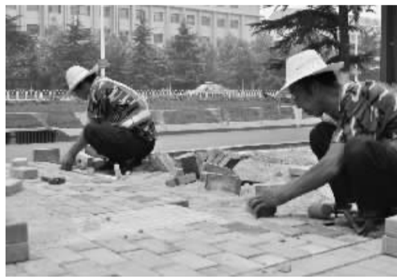
■施工人员紧张地进行作业。
