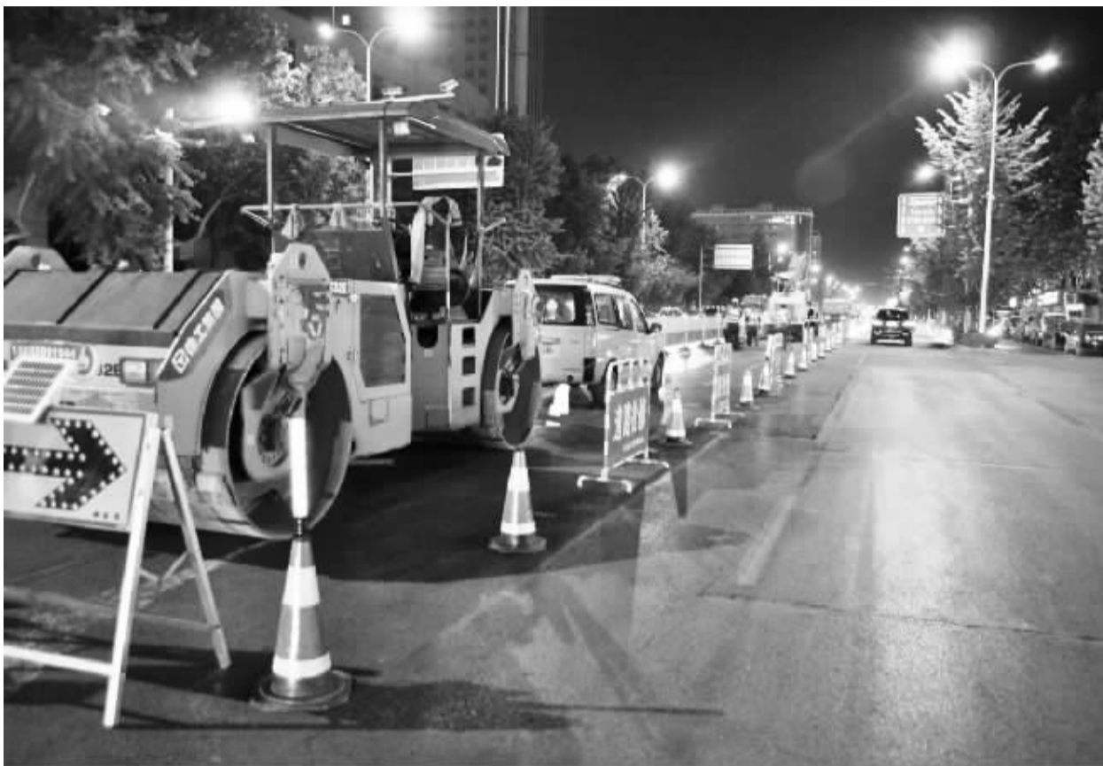
■在夜间实施路面维修。
