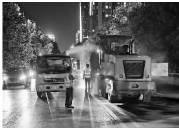
■夜以继日,加紧施工进度。
