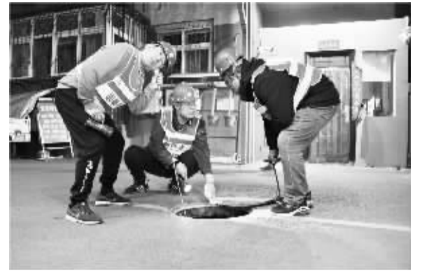
■供水“夜行人”在对地下管网巡检探漏。
