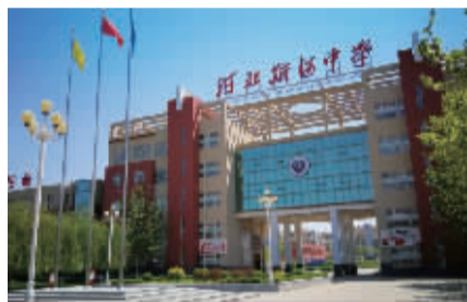
■ 河北新河中学校园风貌
