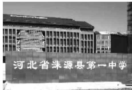
正在建设中的涿源一中新校区
