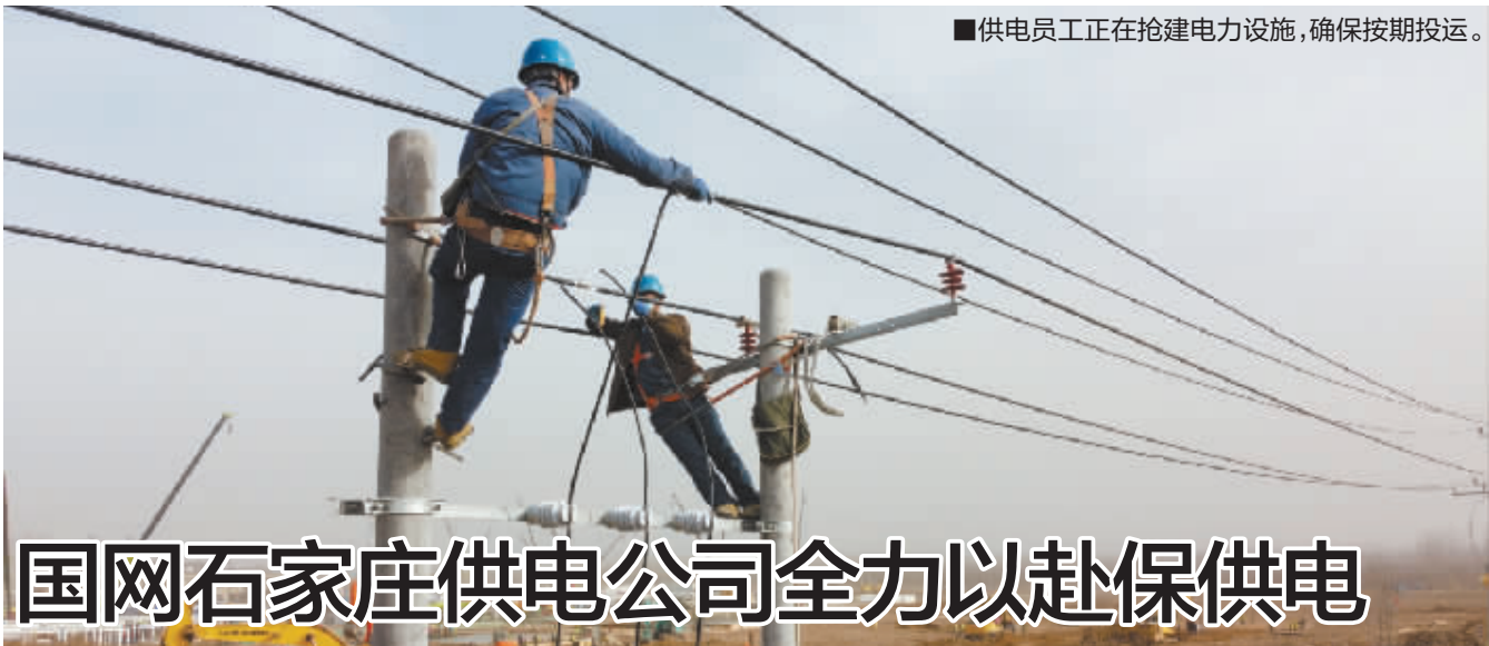
■供电员工正在抢建电力设施,确保按期投运。
