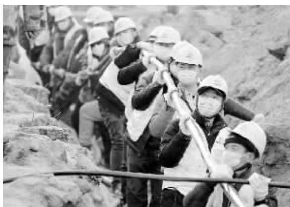
■施工人员在电缆沟中敷设电缆。
