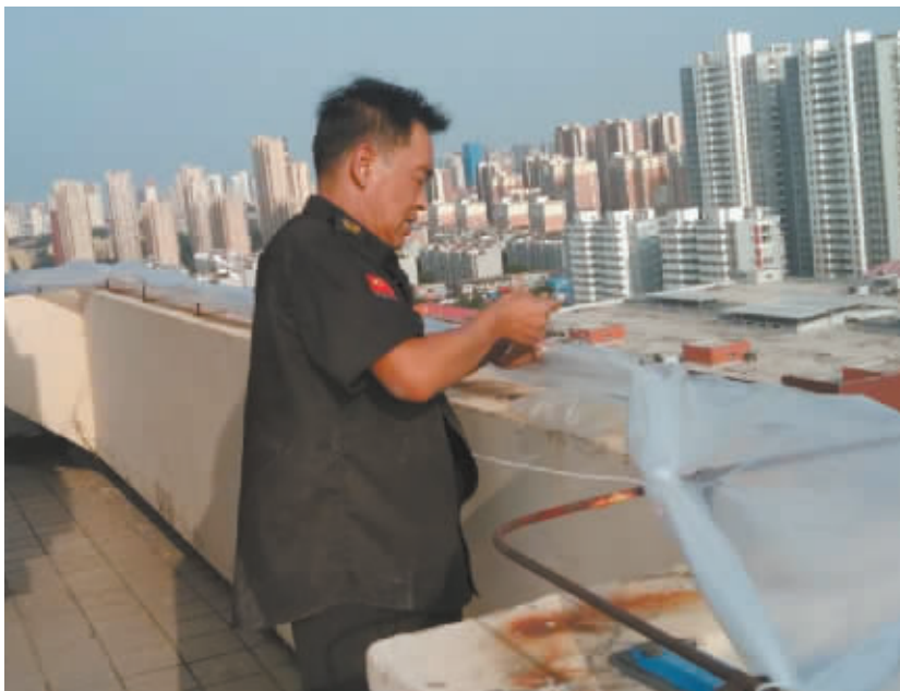
■肖跃民在维修小区设备(资料图片)。 物业供图
