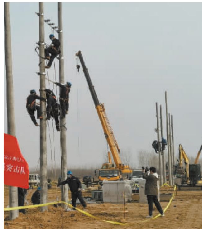
■电力配套设施建设同步进行。
