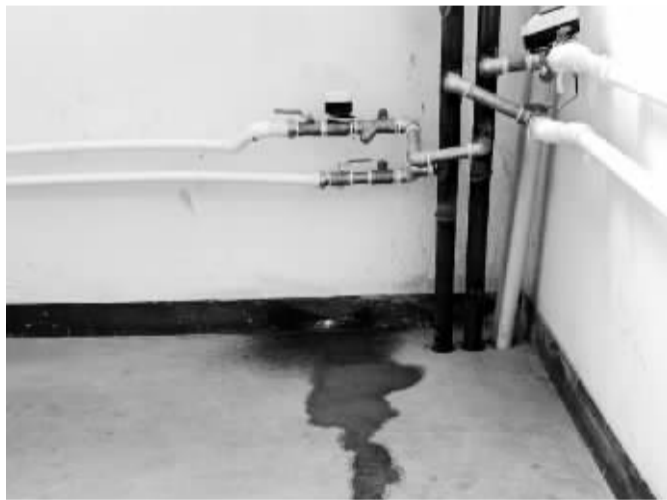
■楼道供暖管网连接处漏水。
