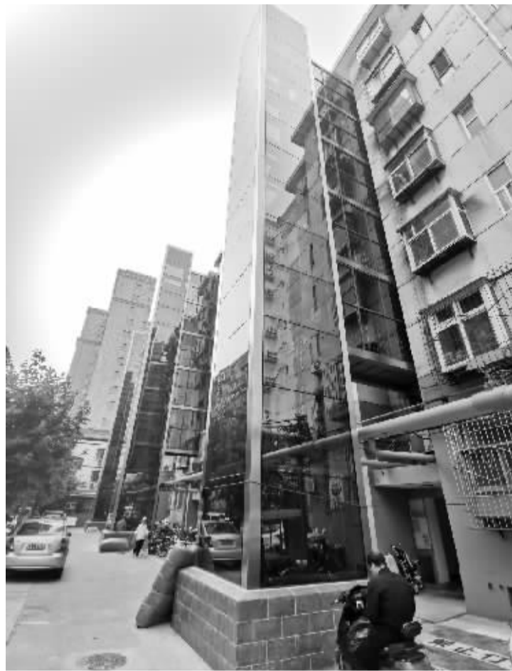
■华泰家园9号楼正在安装的“公交电梯”。
