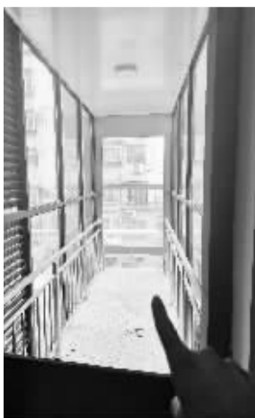
■电梯轿厢还未安装。
