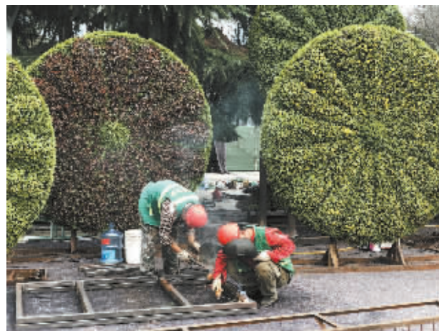
■工人正在焊接花架。
