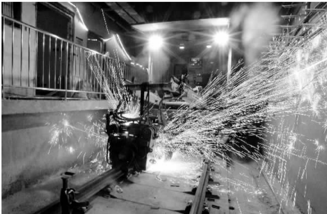
■焊接最后一组钢轨。本报记者 郗磊 摄
