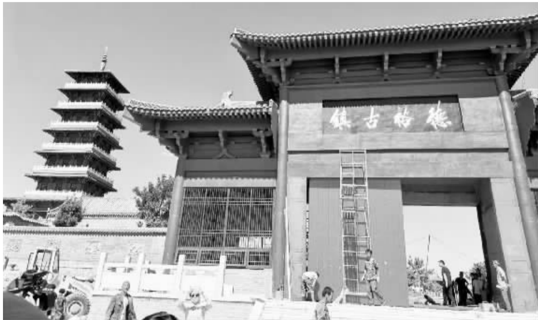
■正在建设中的德裕古镇。
