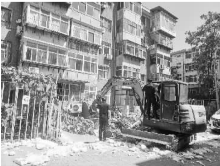
■青园小区拆违建现场。(本报首席记者 杜慧 摄)
