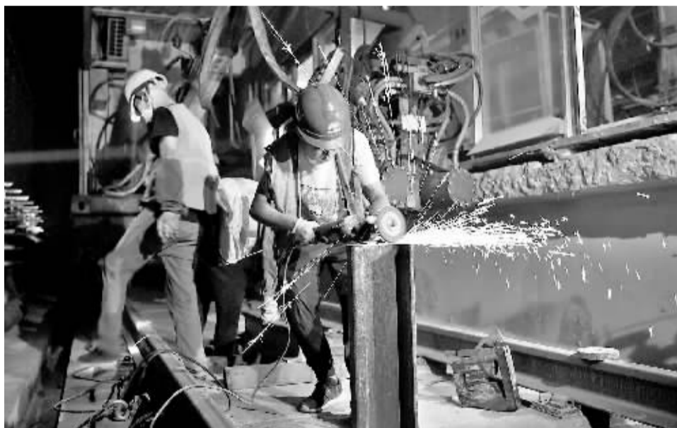
■施工人员在隧道中忙碌。 本报记者 郑磊 摄
