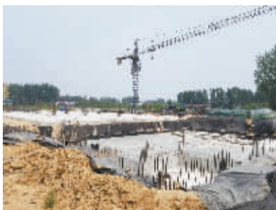
易县民心工程之一、新建的易县中医院紧张施工。
