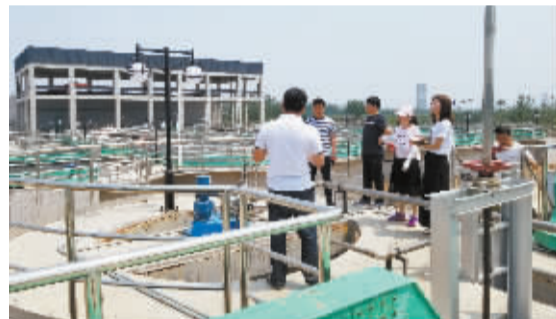
易县“双创双服”办公室和大项目办对污水处理厂项目现场督导。
