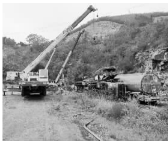
■现场处置柴油泄漏事故。(警方供图)
