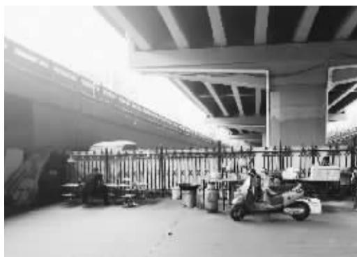
■和平路与建设大街交叉口高架桥下方通道内的摊点。
