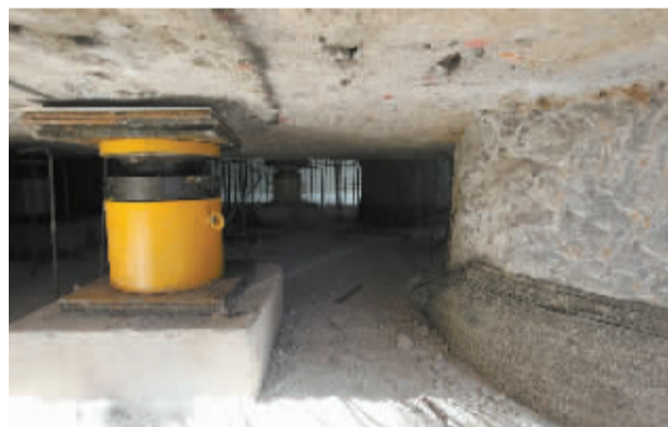
■液压千斤顶支撑桥体。
