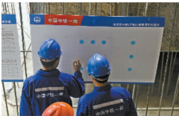
■施工人员记录施工的相关信息。
