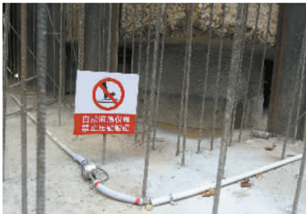
■施工中,多个自动检测仪器精准检测。
