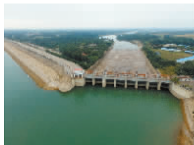
正常溢洪道闸门。
