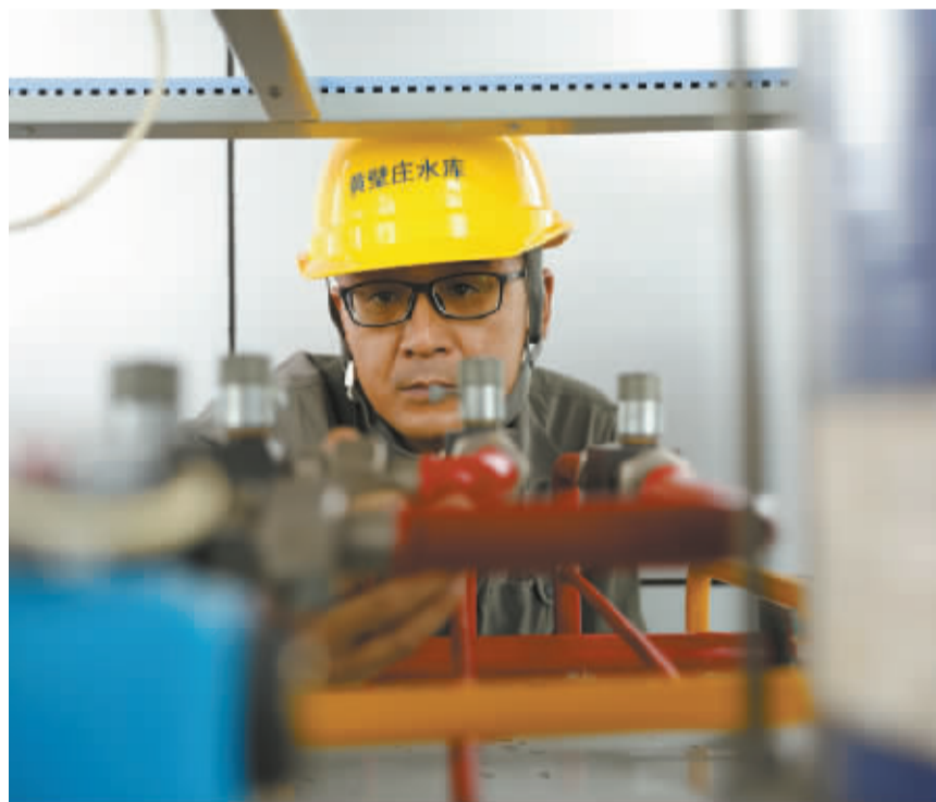
检查液压设备。
