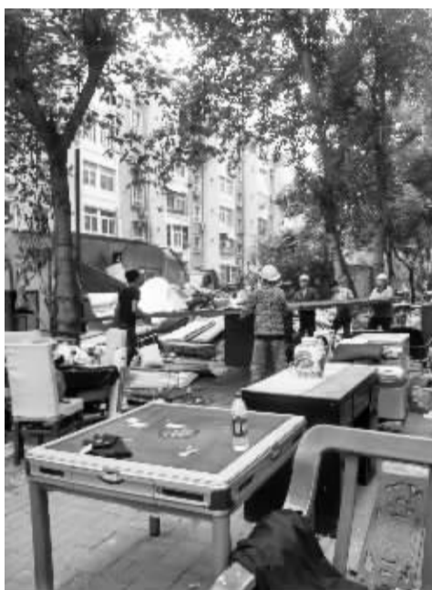
■长安区建安街道在棉一西区拆违1600多处。
