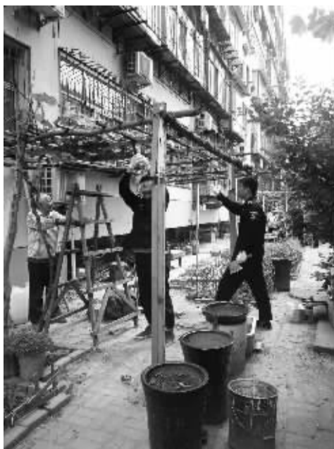
■新华区中院宿舍拆违大快人心。
