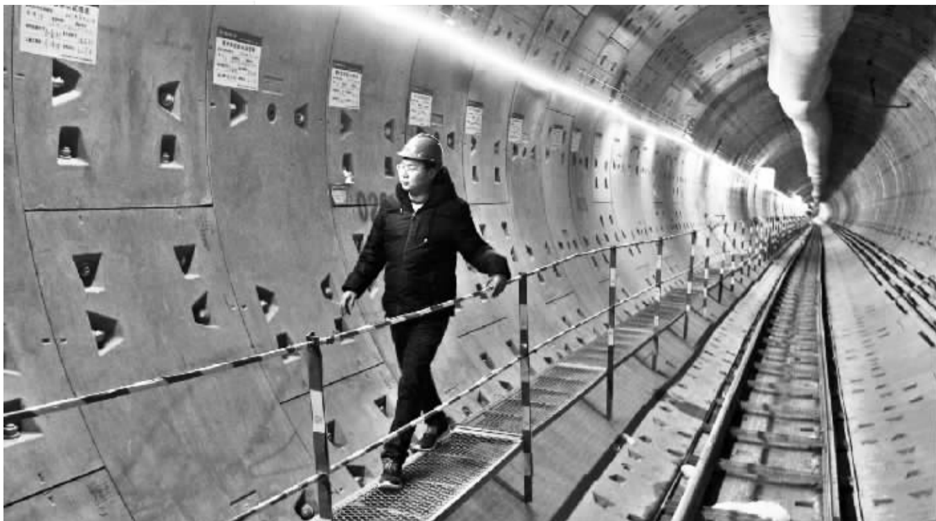
■地铁隧道“洞通”。
