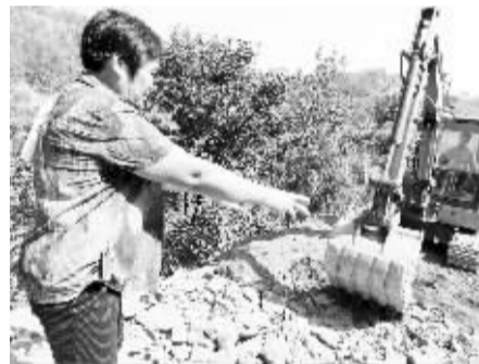
■徐改金指挥小型挖掘机平整上山的路面。
