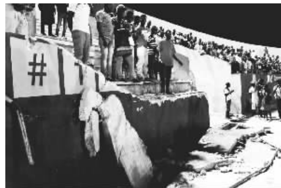
■发生倒塌的看台。 新华社发
