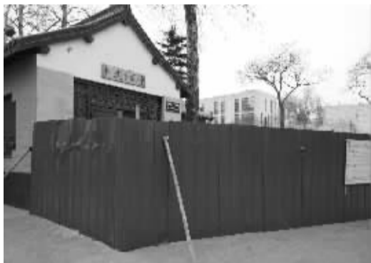
■裕西公园东南角公厕被围挡完全封闭,无法使用。
