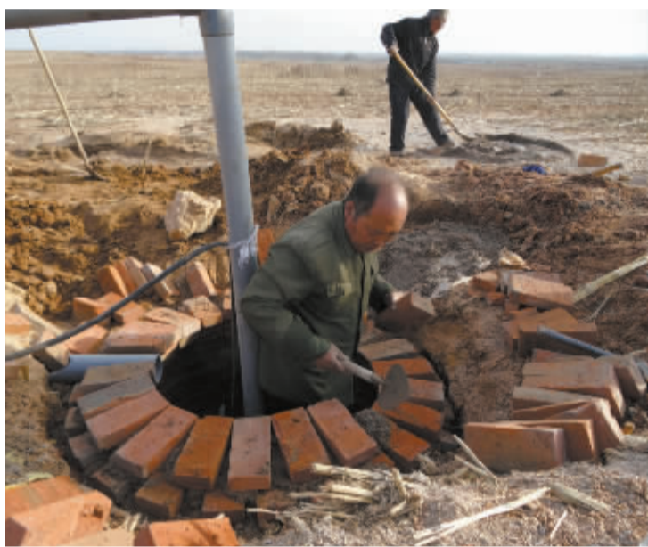
■工人正在砌井口。
