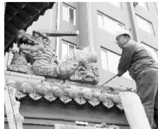
■工作人员正在小心翼翼地拆除仿古琉璃瓦。
