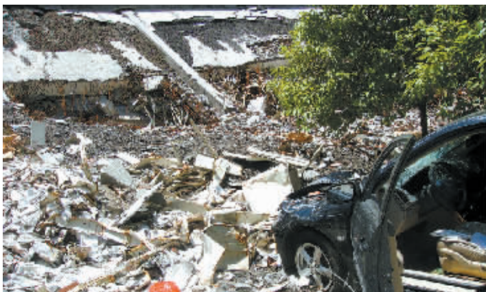
倒塌后的县委礼堂。 李宏 摄
